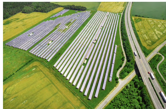
De transformatoren logisch plaatsen in het zonneveld
